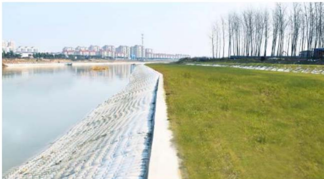
图2-2 淮安区钦工镇模袋混凝土护坡现状
