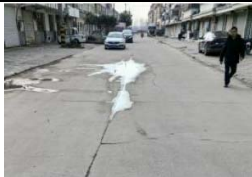
桃园小区上堤道路现状
