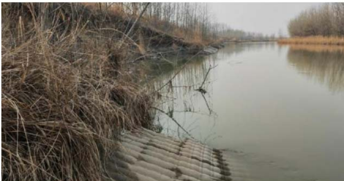
图2-3 淮安区甘姜段模袋混凝土护坡现状
