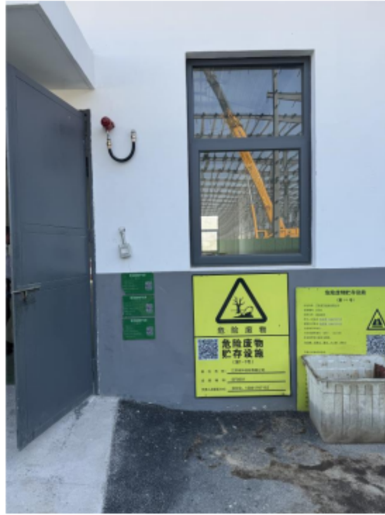
图 2-11 危险废物仓库照片
